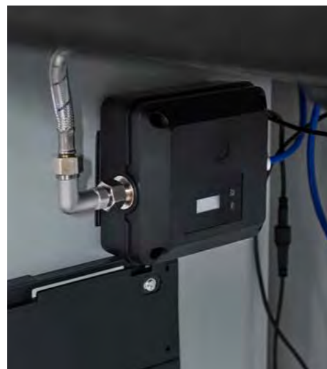
Platzsparend und übersichtlich: Die Steuereinheit zeigt auch die Restkapazität des Filters.
